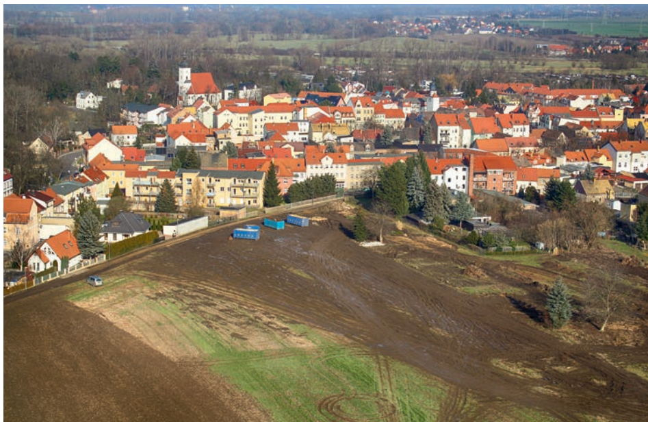
Das Wohngebiet Schiefer Weg in Groitzsch kurz vor dem Start der Erschließungsarbeiten.
